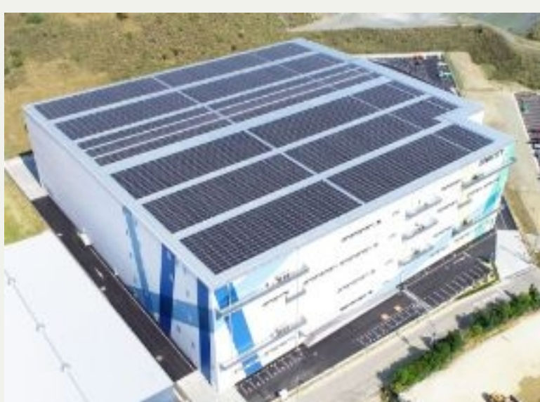
設置方式：屋根置き 福岡県古賀市
