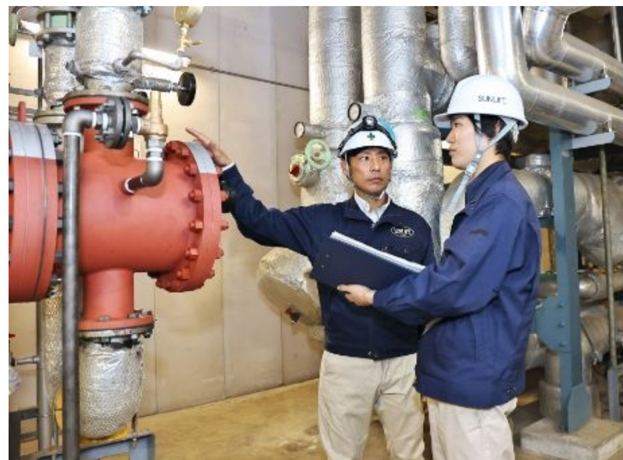
熱源設備改修工事
