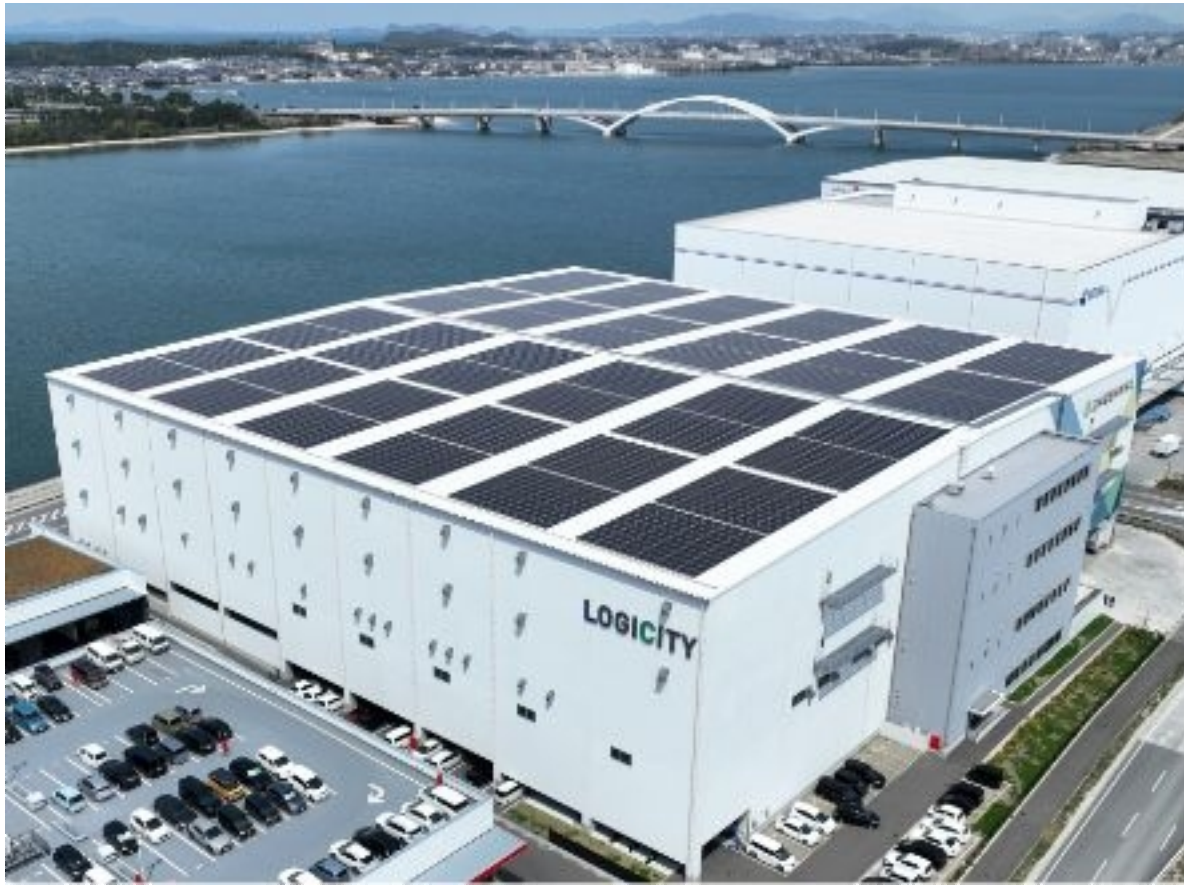
設置方式：屋根置き
