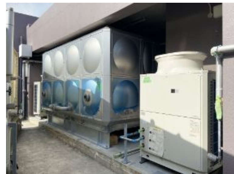
九電ケアタウン：給湯システム改修工事 福岡県福津市
