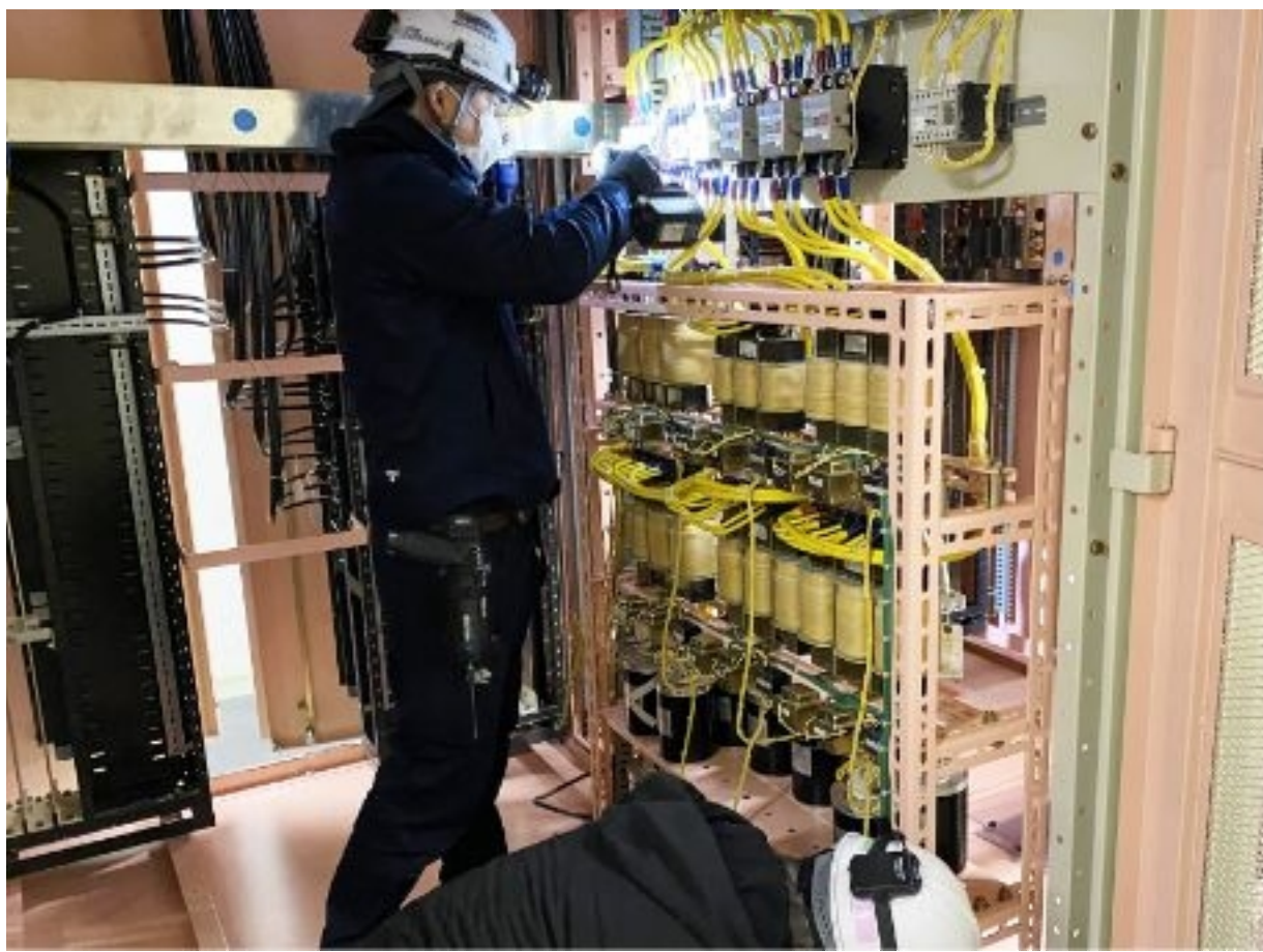
受変電設備更新工事
