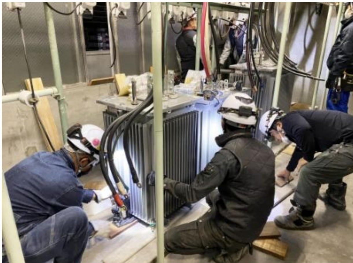
受変電設備更新工事
