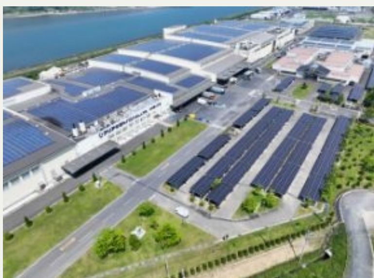
設置方式：屋根置き・カーポート 長崎県北松浦郡
