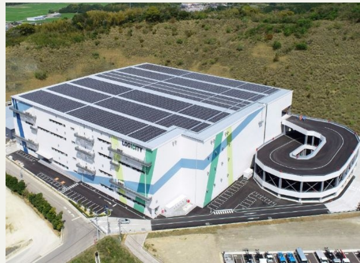
ロジシティ古賀 福岡県古賀市
