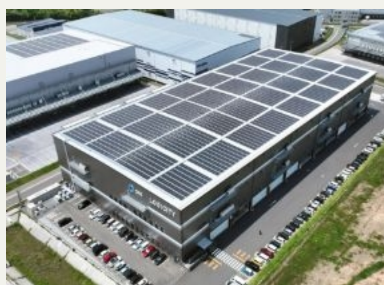
設置方式：屋根置き 福岡県小郡市
