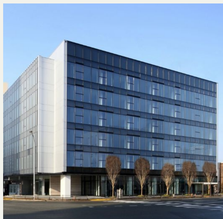
東比恵ビジネスセンターII 福岡市博多区
