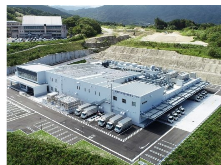
福岡県福岡市第3給食センター 福岡市西区
