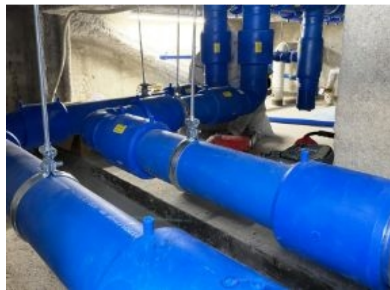
福岡ワシントンホテル：給排水配管更新工事 福岡市博多区
