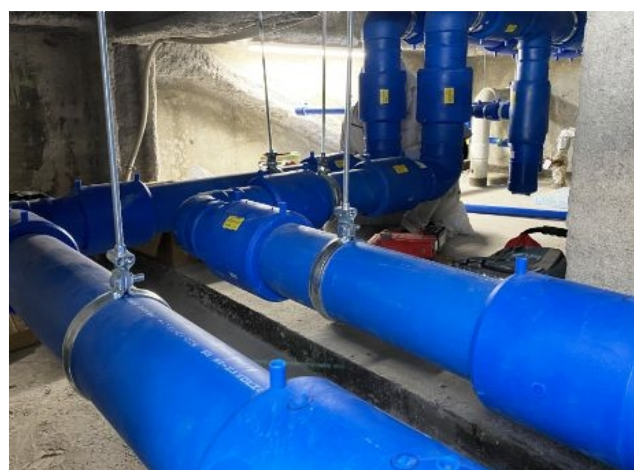
給排水・衛生配管更新工事
