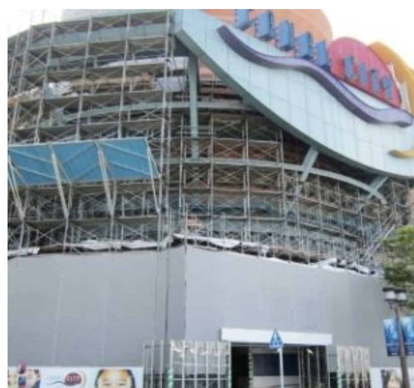
外壁改修工事（キャナルシティ博多）
