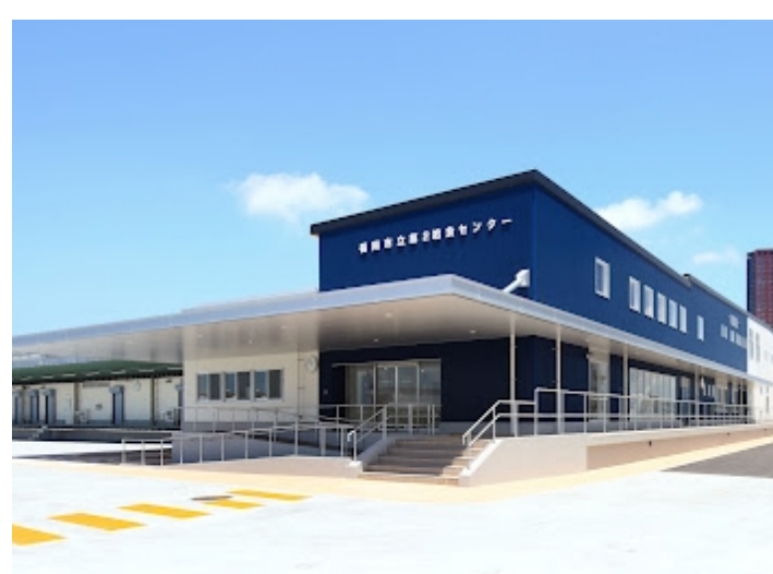
福岡県福岡市第2給食センター 福岡市西区
