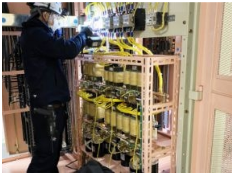
キャナルシティ博多：受変電設備更新工事 福岡市博多区
