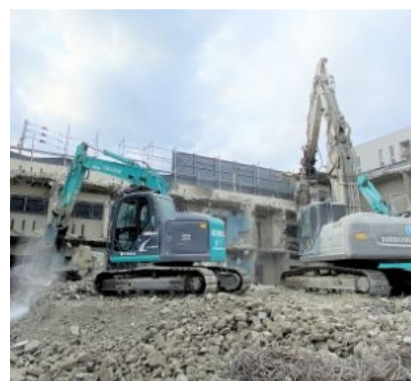
解体工事（某銀行社宅）
