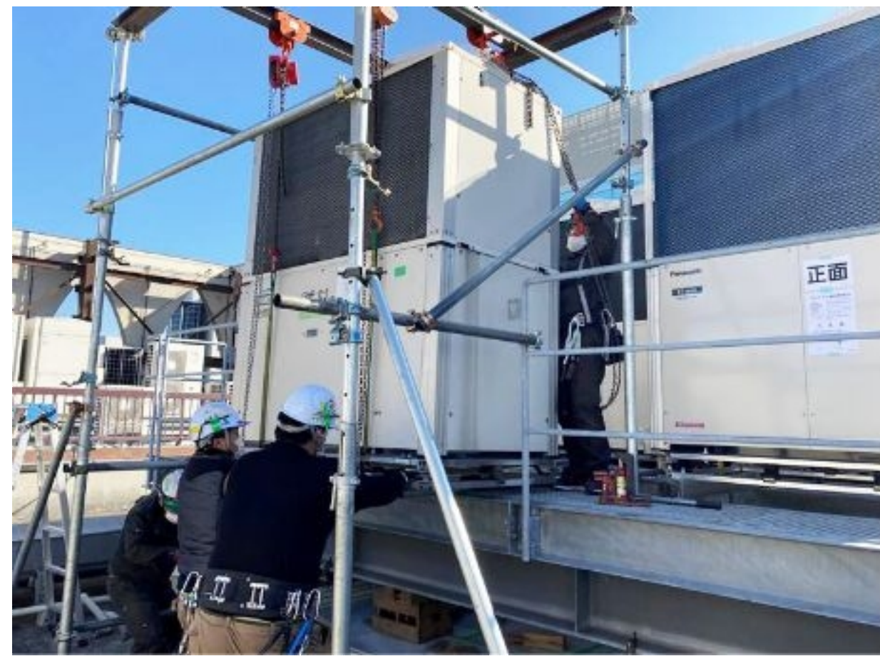
空調設備改修工事
