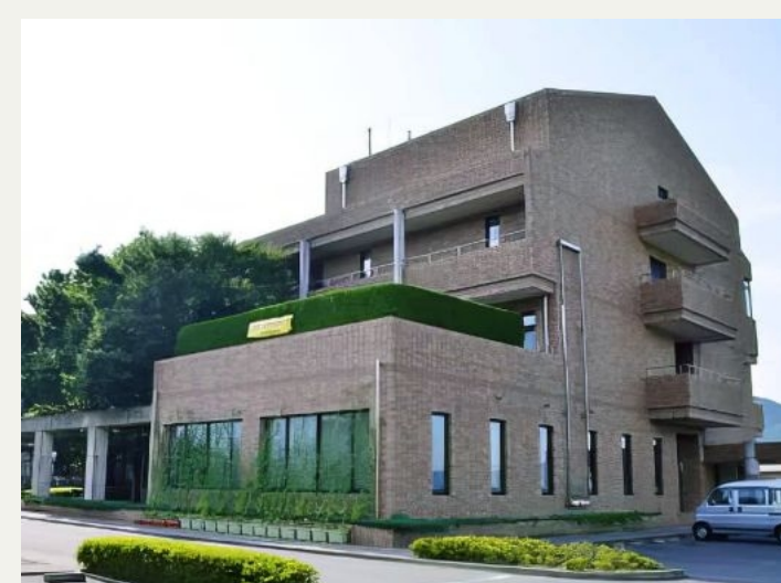
糸島市交流プラザ二丈館 糸島市
